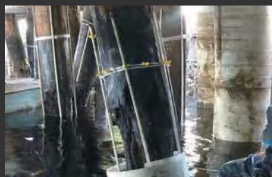
附着在桩上的垫片和FRP钢筋
