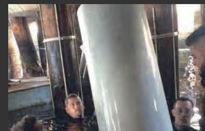
在灌注灌浆料之前安装 PileMedic®护套
