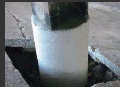
用 PILEMEDIC® 加固后的截面
