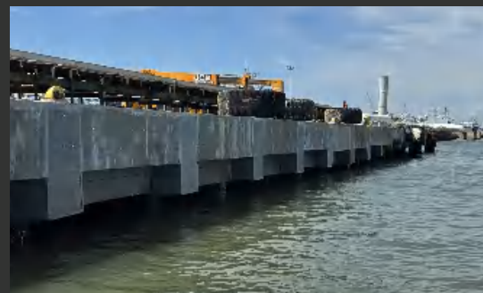
定制层压板固定于原有结构之上 环状间隙填充树脂材料或者注浆
